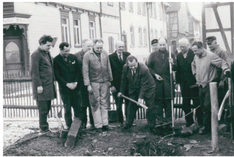
Spatenstich für die neue Montagehalle in der Georgiistraße, Frühjahr 1966. Der Neubau entstand dort, wo zuvor verschiedene Handwerksbetriebe, die sogenannten Keffelschen Gebäude, gestanden hatten.
