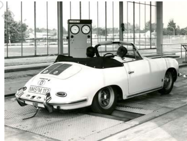
Unten links: Bremsentest in der Prüfstelle Neumünster, um 1965.
