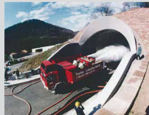
Vielfältige Einsatzmöglichkeiten: testweise Belüftung eines Straßentunnels mit dem Turbo-Löcher.
