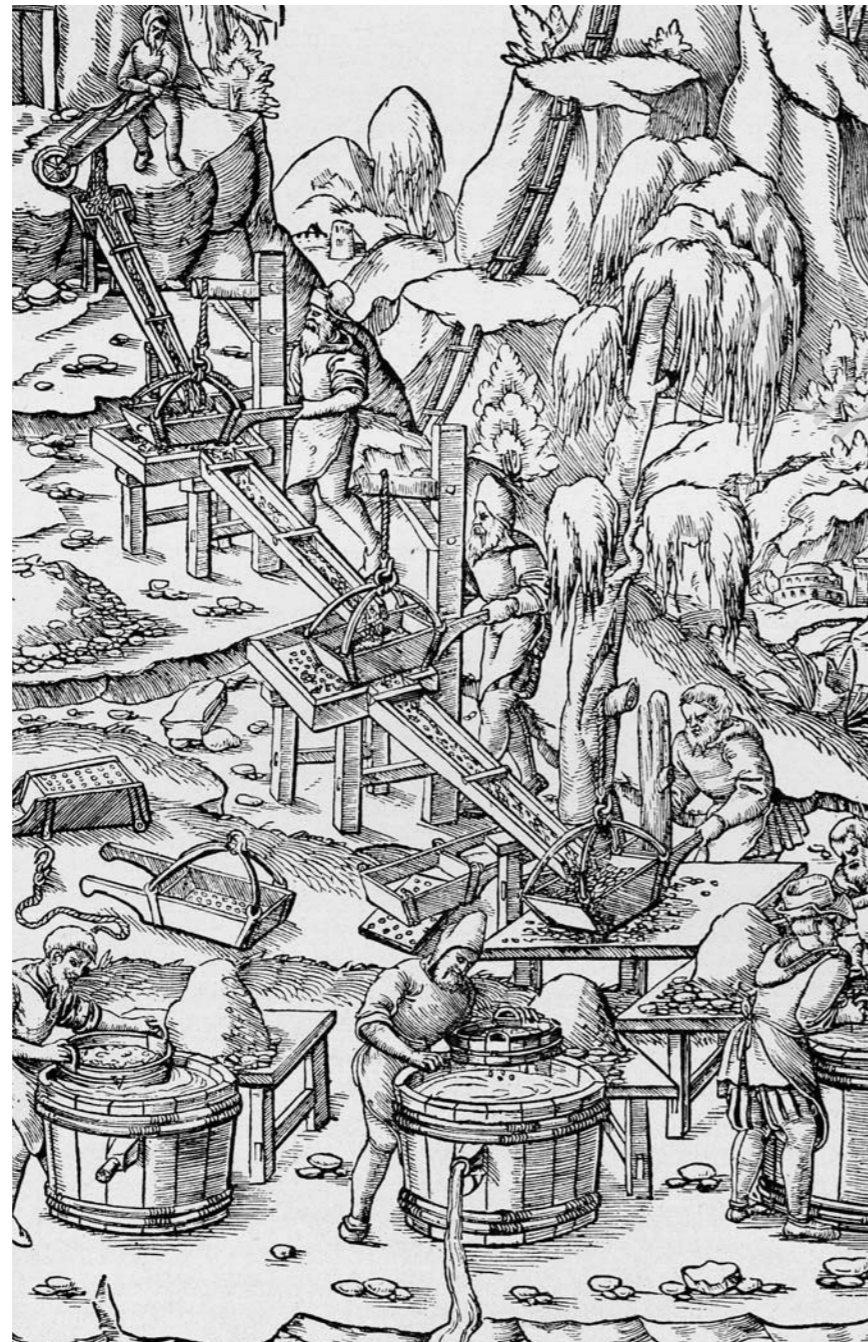
Erzwaschung. Darstellung aus De re metallica von Georgius Agricola, 1556.
